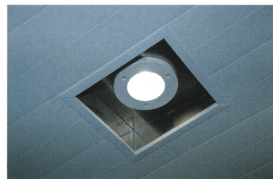
ステンレスボックスに「レディオック LEDダウンライト 軒下用 クラス350」を収めることで勾配面がフラットな形になるように設置している。 LEDioc LED Downlight (Under Eaves Use: class350) units have been housed within stainless steel cases, so as to enable a flat gradient surface when installed.
