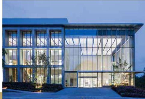
講義室は柱梁アウトフレーム構法とPC床版による彫の深いグリッド形状を特徴としている。縦横の庇効果により居住域の日射抑制と工期短縮と講義室の無梁化が可能となつた。
