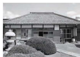
改修前の写真
